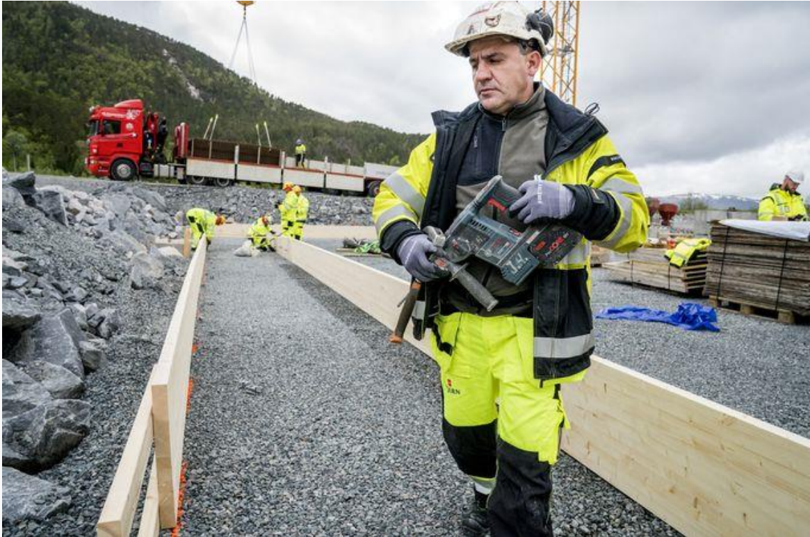
Betongstøping: Andrzej Hajduk i Stjern Entreprenør er i gang med å forberede støping til det som skal bli et underjordisk anlegg med ti kilometer rør som skal ligge under smoltanlegget. FOTO: MORTEN ANTONSEN
