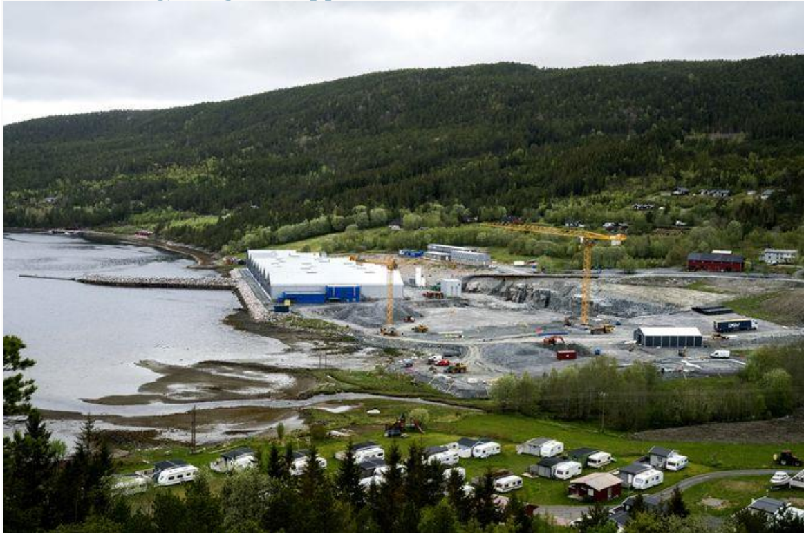
Laksefabrikk: Belsvik i Heim er allerede et stort anlegg for laksesmolt, men skal bli enda mye større etter en investering på 600 - 700 millioner kroner. FOTO: MORTEN ANTONSEN
